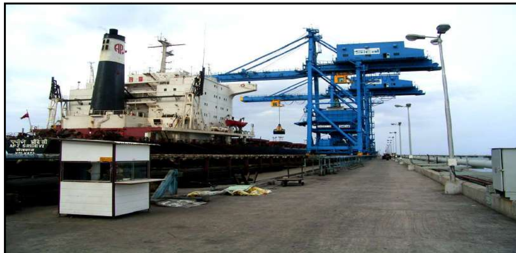
Figure - 1.1.Tangedco berth
